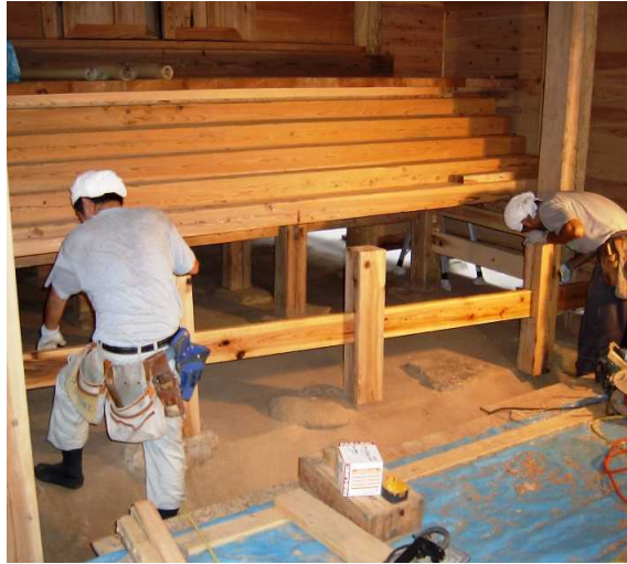
本殿の階段は既存のものを削って使用し、交換した構造材も従来の寸法を再現
